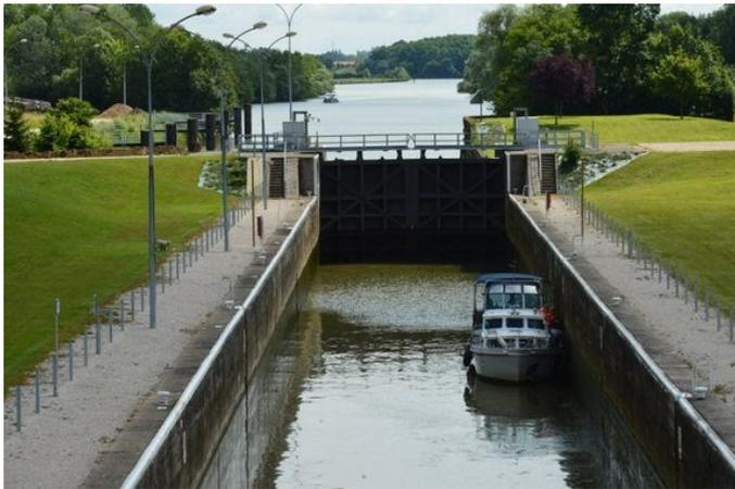
Les écluses sont utilisées pour permettre aux bateaux de descendre et remonter des fleuves dont la pente est trop importante.
